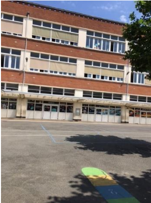
Le bâtiment principal
